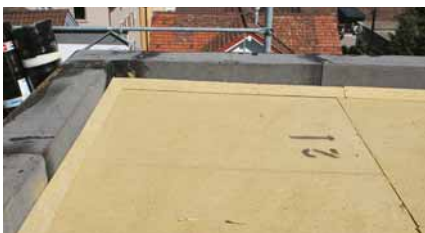
Dachrandkeile bei Aufbordungen im Flachdach.
