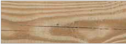
Trocknungsrisse (nach DIN zulässig)
