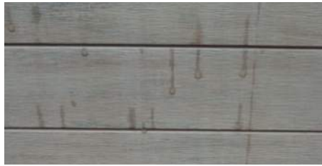
Fleckenbildung durch von Regen angelöste Partikel
